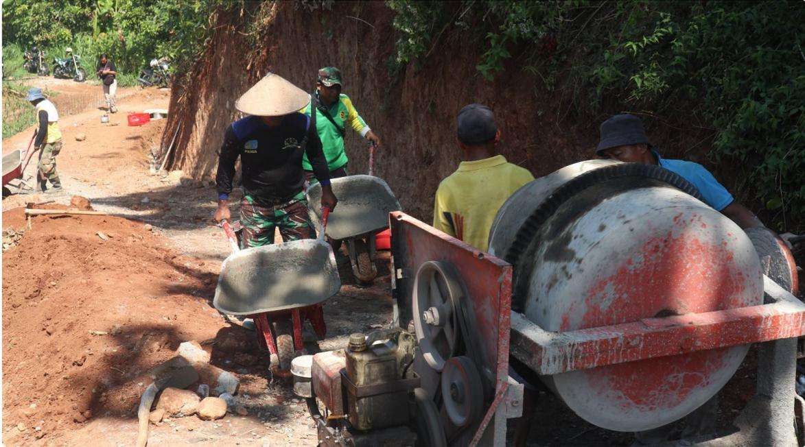
Adapun program yang akan dilaksanakan pengecoran jalan sepanjang 298 meter, lebar 3 meter dan tinggi 0,15 meter serta talud sepanjang 56 meter dengan ketinggian bervariasi mulai ketinggian 0.90 meter hingga 2.40 meter, pungkasnya.
