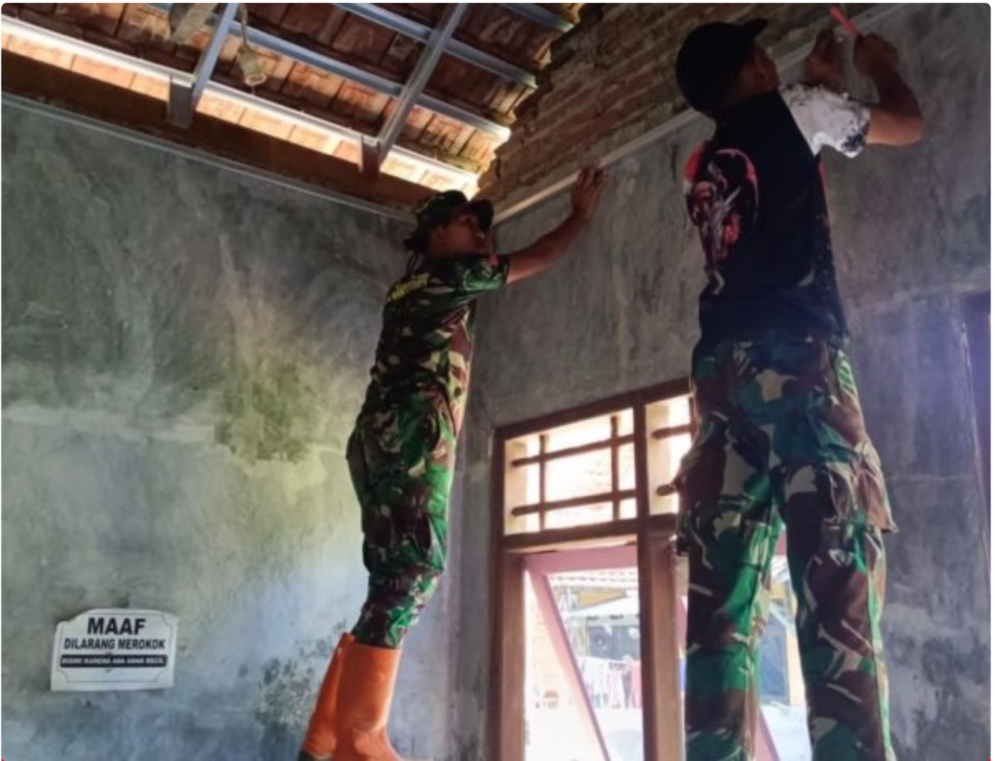
( Foto istimewa) satgas tmmd pasang kerangka plafon RTLH
